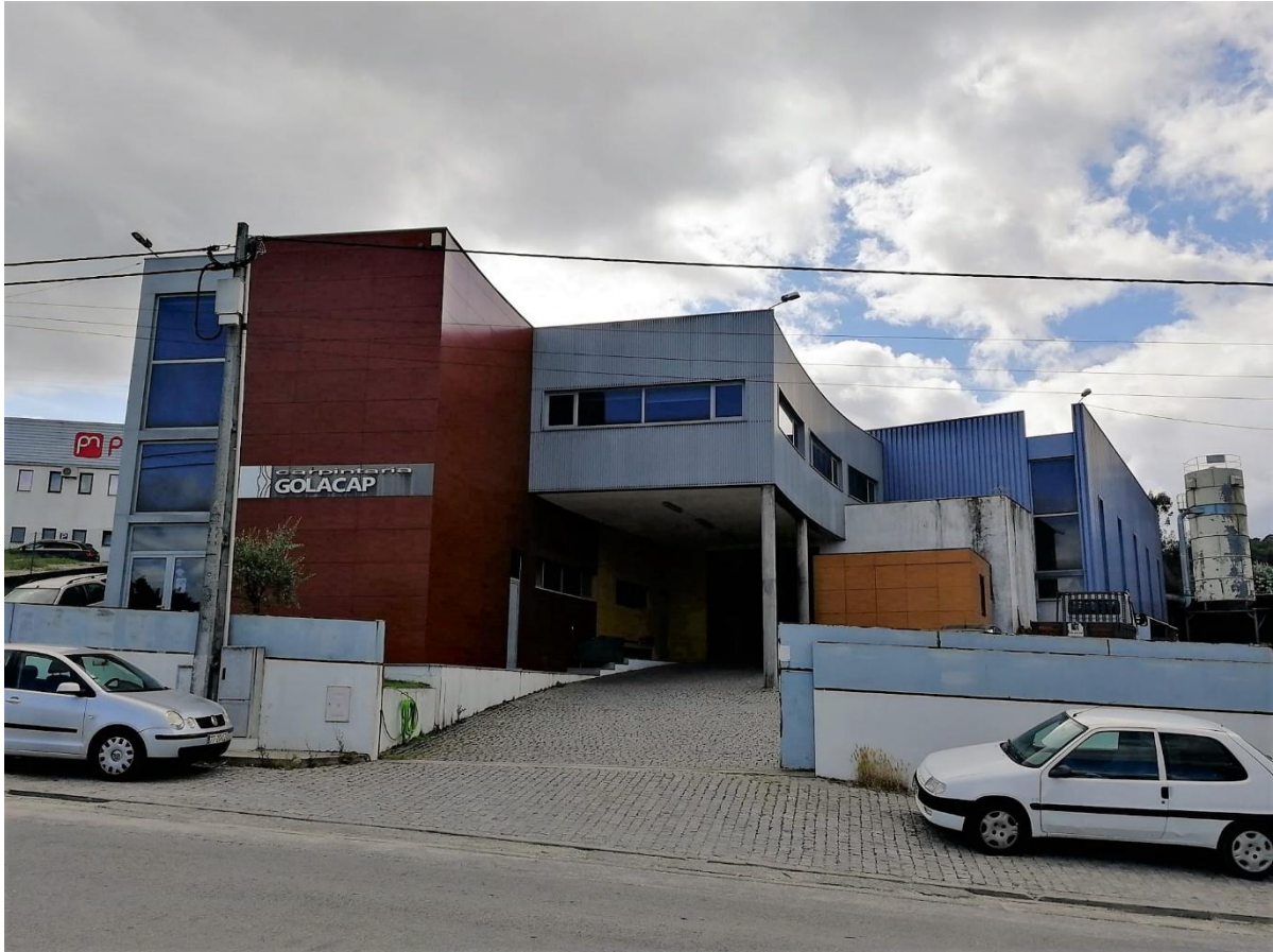
F1_Entrada da empresa na Rua Monte da Pena
